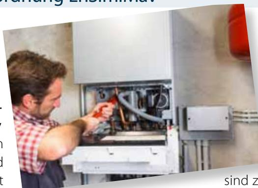
Laut der „EnSimiMav“ sind Gas-Heizungsanlagen bis zum 15.09.2024 zu überprüfen und ggf. zu optimieren. Bei Mehrfamilienhäusern ist ggf. ein Hydraulischer Abgleich vorzunehmen.
